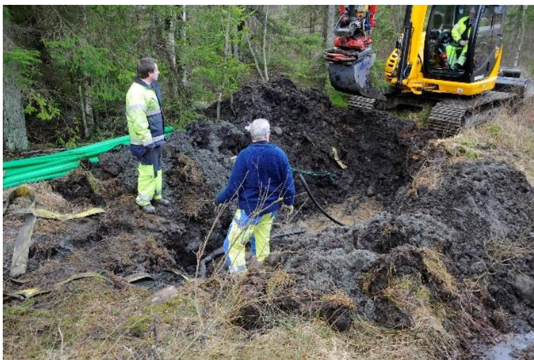
Avgrävd 10 KV-kabel i Näs
