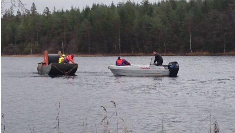
Läggning av sjökabel
