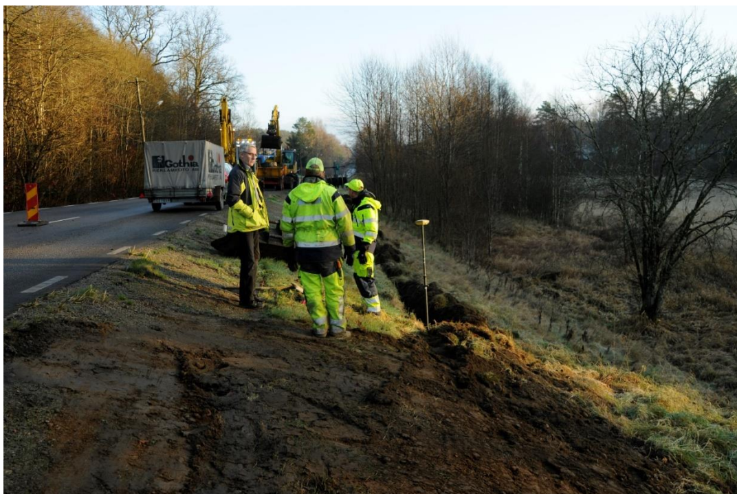
Allt måste gå rätt till. Kontroll av inmätningen (Donald)
